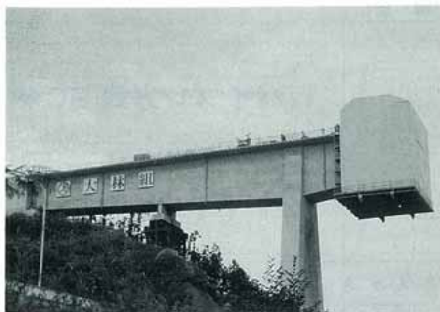
写真-5 シートで覆った移動式作業車
