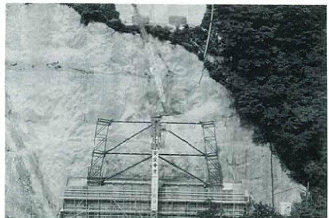
写真-3 橋脚の施工
