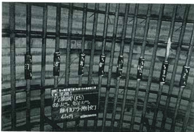
写真-2 深礎杭内の鉄筋継手
