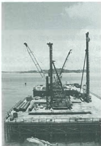
写真-3 作業用栈橋上からの杭施工
