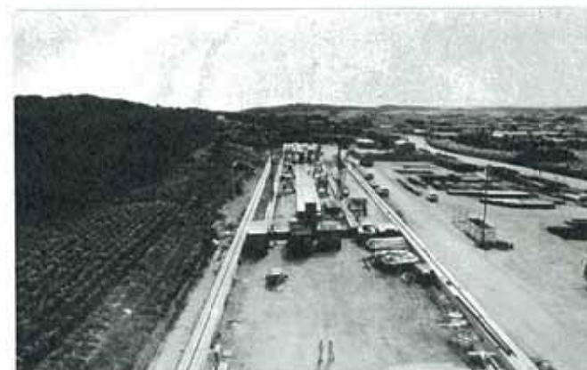
5) ブロック製作ヤード施工中
