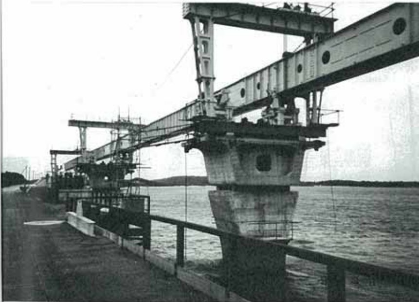
9) エレクションガーダーの架設
