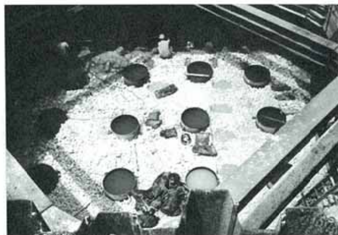
3) 鋼管杭打設完了
