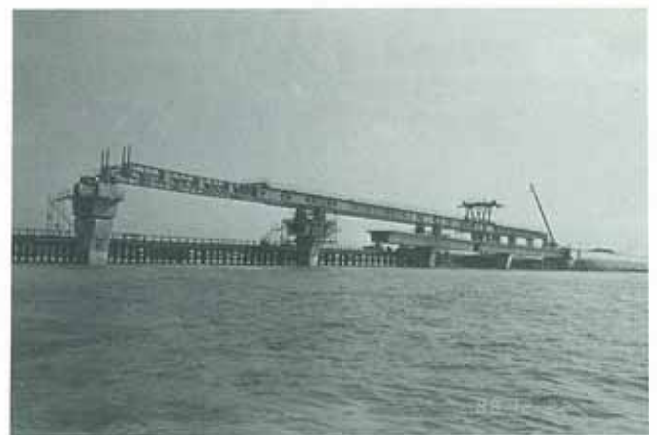
写真-1 架設中の池間大橋
