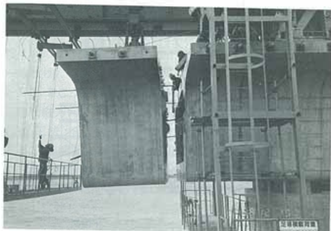
写真-6 エレクションガーダーによるブロック架設
