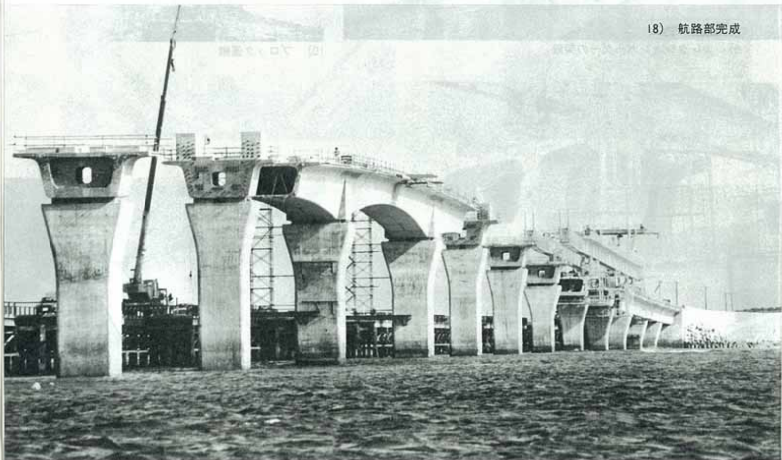
17) 航路部の張出し架設(現場打ち)
