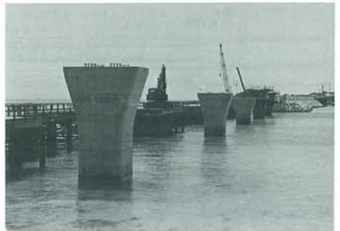
写真-4 完成した橋脚
