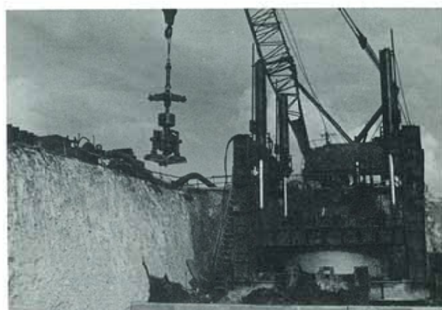
写真-2 PCウエルの沈設
