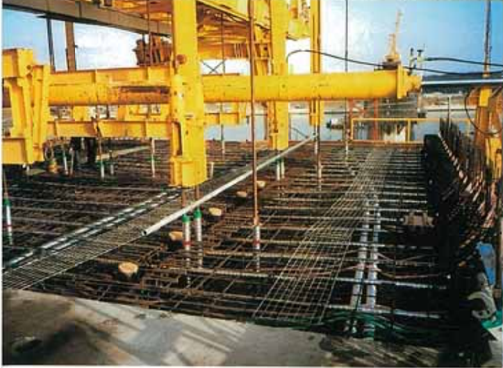
7) 10mのブロック施工
