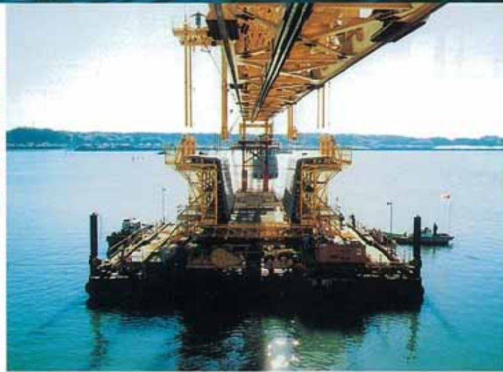
3) 型枠装置の吊上げ
