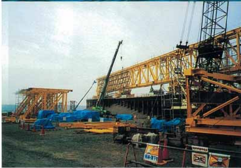
2) P&Z 装置送り桁の組立て
