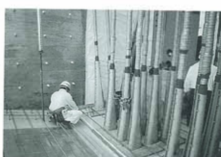
写真-5 鉛直方向鋼材のトランペット型シース
