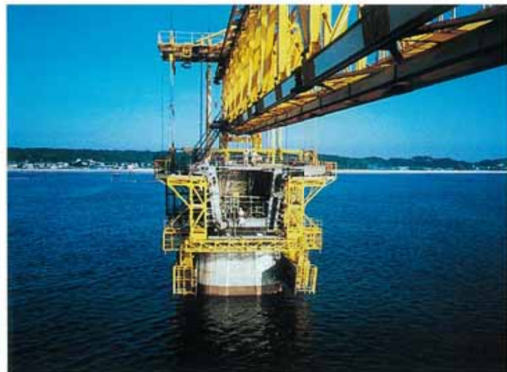
5) 柱頭部の施工完了
