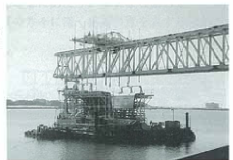
写真-2 型枠装置の吊り上げ
