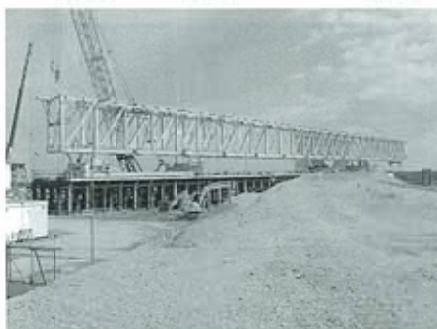
写真-1 構台上での送り桁の組立て
