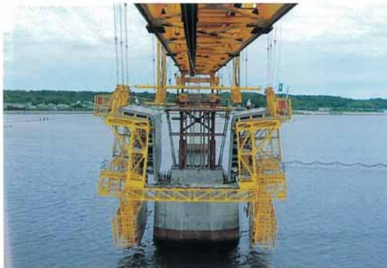
4) 柱頭部への型枠装置の移動
