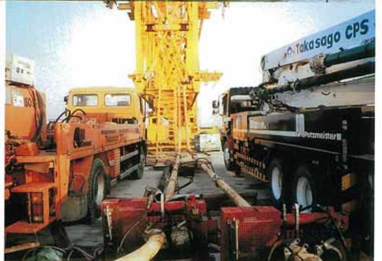
8) 送り桁後端からのコンクリート圧送
