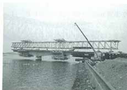
写真-3 P&Z装置を用いた側径間吊り支保工
