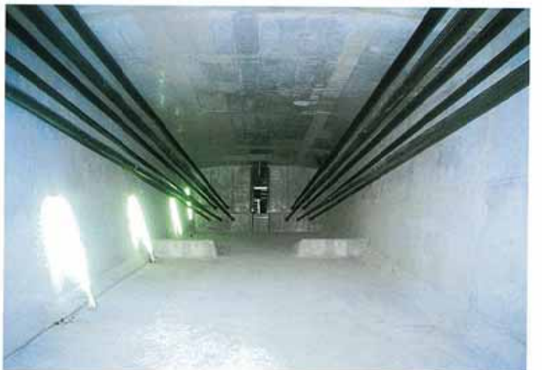
10) 外ケーブルおよび箱桁内部
