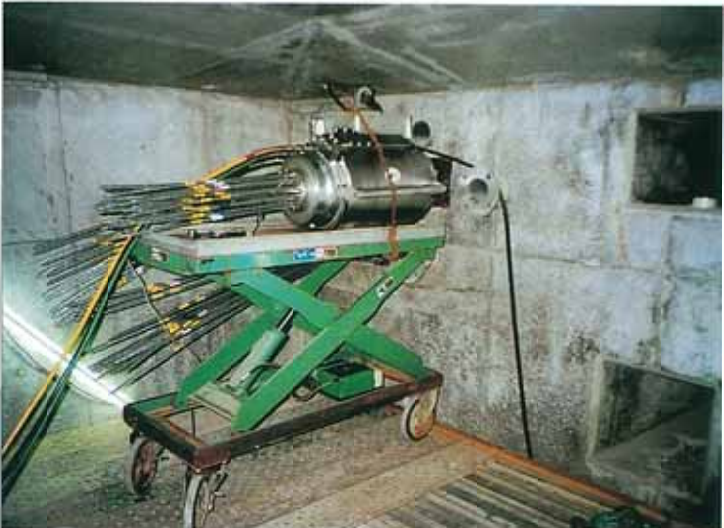
9) 外ケーブルの緊張
